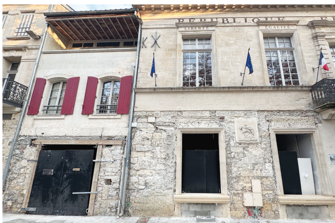
Réfection façades - Amélioration déperdition thermique
