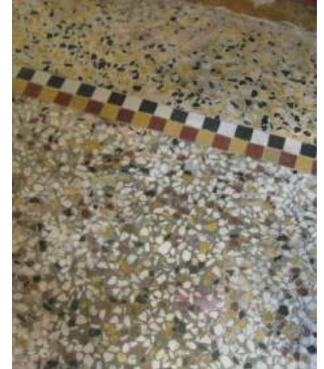
Sol des entrées d'immeuble ou des pièces principales en rez-de-chaussée réalisés en terrazo.
