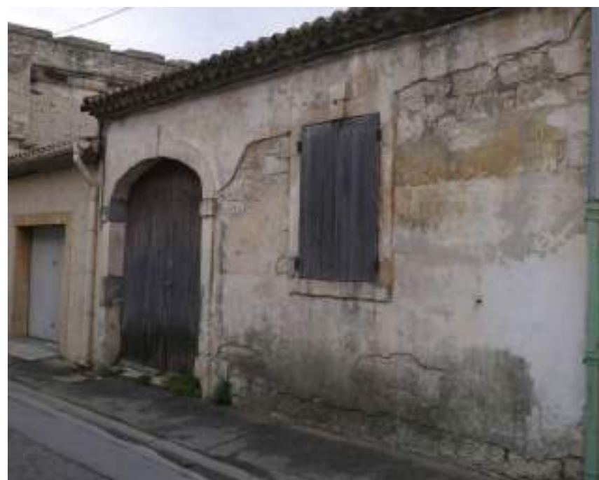
La densité et l'imperméabilisation des rues soumet le bâti aux remontées d'humidité.
