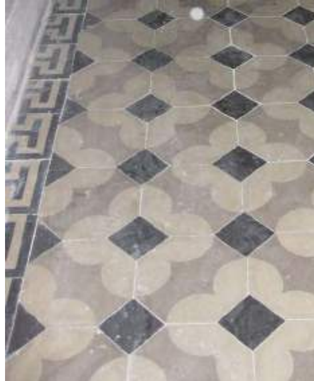
Sol revêtus de carreaux en ciment coloré fréquemment utilisés fin 19e siècle.
