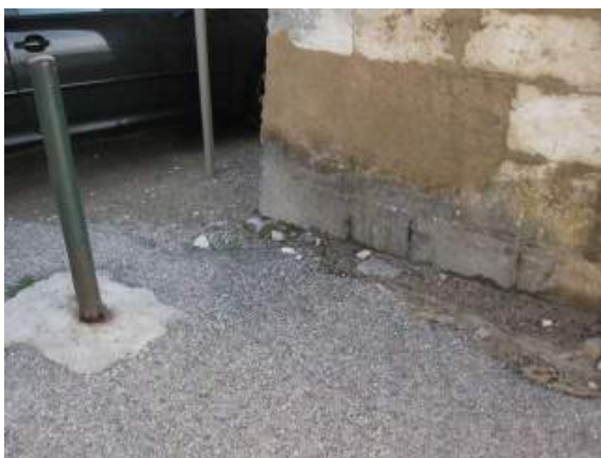
Imperméabilisation des sols et par conséquent dégradation des massifs de pierre. Perte progressive du repère du sol originel par l'accumulation des couches de revêtements de sol.
