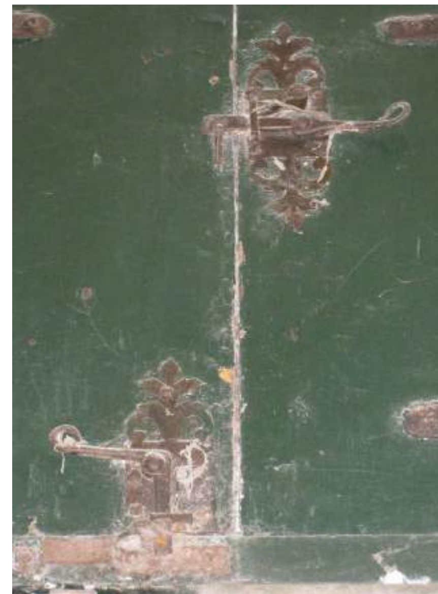
Loquets et targettes 18e siècle, rarement observés.
