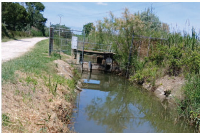
Entretien réseaux hydrauliques
