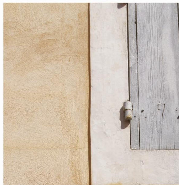
Volet de fenêtre gris, enduit ocre jaune clair et encadrement enduit avec un mortier de chaux blanche
