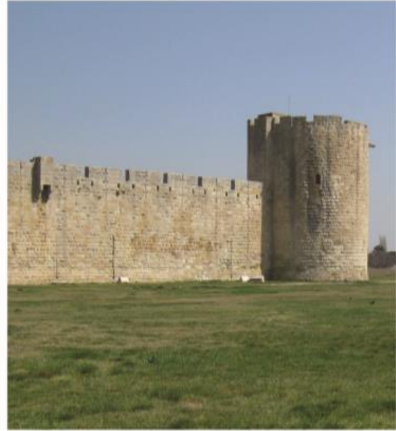
Remparts sud, vue de la Tour de la Poudrière
